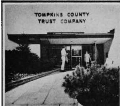
Main Office, 110 N. Tioga St.
